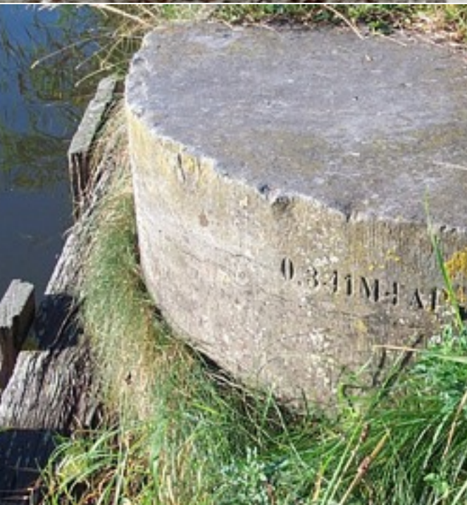
Een peilmerk op de Inlaatduiker aan de Starnmeerpolder.
