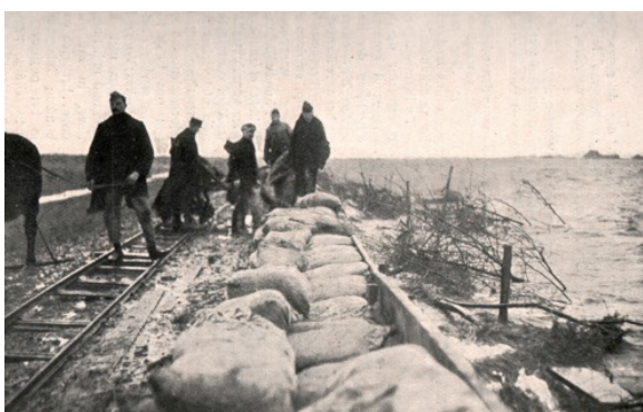
Militaire inzet bij het ophogen van een dijk in het rampgebied. Het is een van de foto's in het geïllustreerde tijdschrift Het Leven jrg.1916 nr.5. (NL-WpDStvA C7118, 1916)
