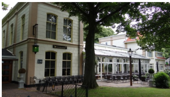
De Officerskantine (gebouw 230) in het bovenkamp ("De Knobbel") van de Legerplaats Oldebroek. (René Ros, 2016)
