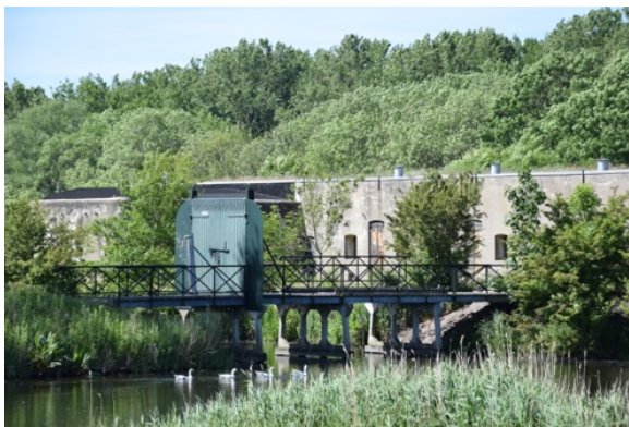
De huidige toegangsbrug van Fort benoorden Spaarndam. Het is een gereconstrueerde brug met 'barrière' (hek) op de betonnen staanders van een latere brug. (René Ros, 2020)
