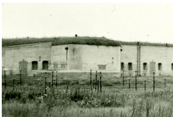
Een prikkeldraadversperring buiten de gracht, met het bomvrije hoofdgebouw en keelkazemat in de achtergrond. Waarschijnlijk is dit Fort aan de Nekkerweg. (NL-WpDStvA C5319, 1940)
