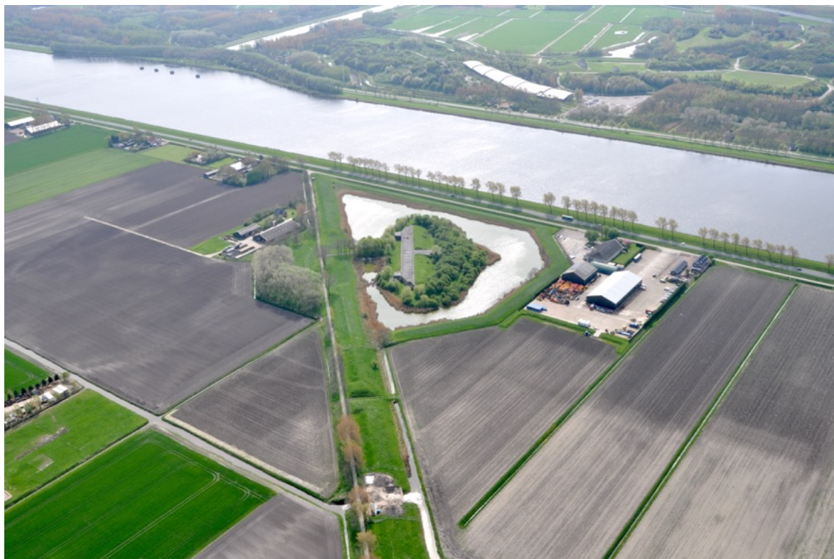
Het Fort Zuidwijkermeer aan het Noordzeekanaal, waar de liniewal op het kanaal aansluit. (Otto Bodemeijer, 2013)
