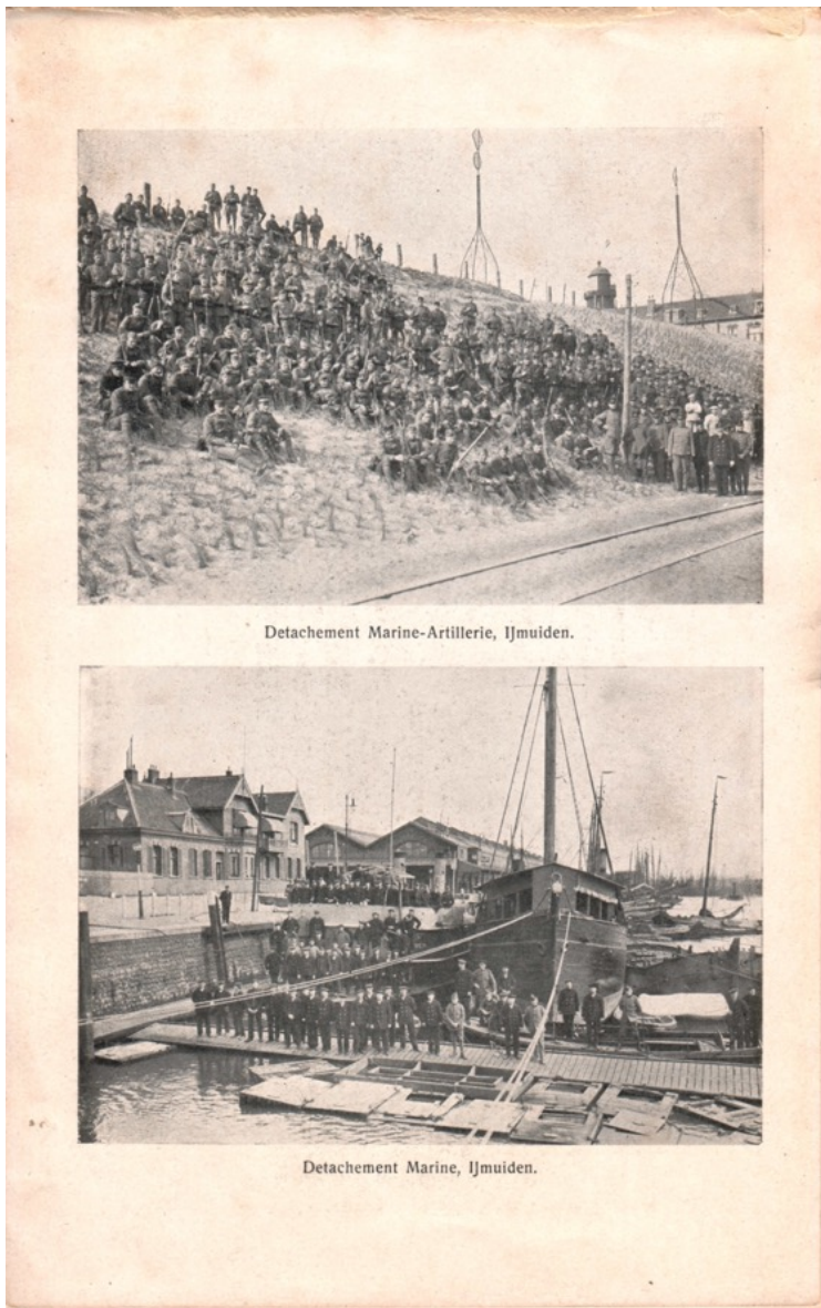
Detachment Marine-Artillerie, IJmuiden. / Detachment Marine, IJmuiden.
