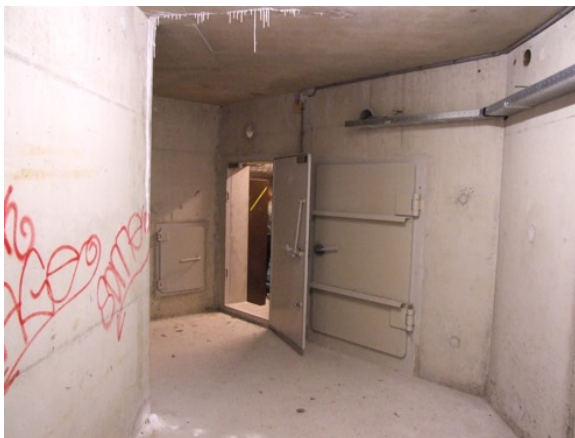
...een luchtinlaat en twee stalen deuren die toegang tot de kelder geven. (René Ros)
