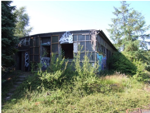
Crew gebouw dat al deels gesloopt is. (René Ros)
