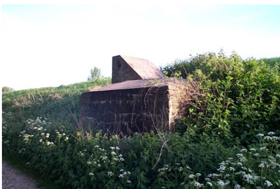
De telecommunicatiebunker. (René Ros)
