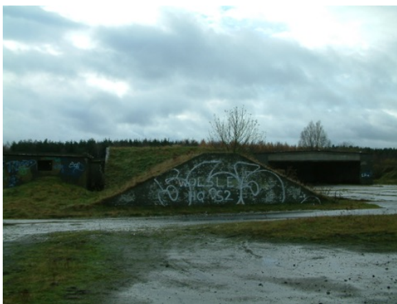
A-sectie met in het midden de wal met de sectie bunker erin. Rechts de hangar en links gebouwen voor verwarming en elektriciteit. (René Ros)
