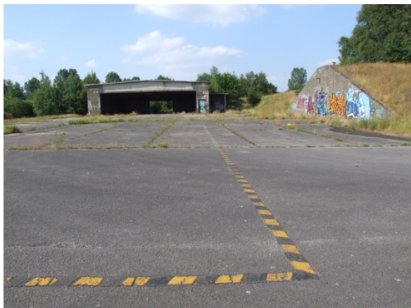
Sectie B met hangar (links) en sectiebunker (rechts). (René Ros)
