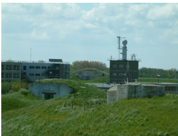
Een overzicht van het Fort Erfprins met onder andere twee remises en een tobruk. (René Ros)
