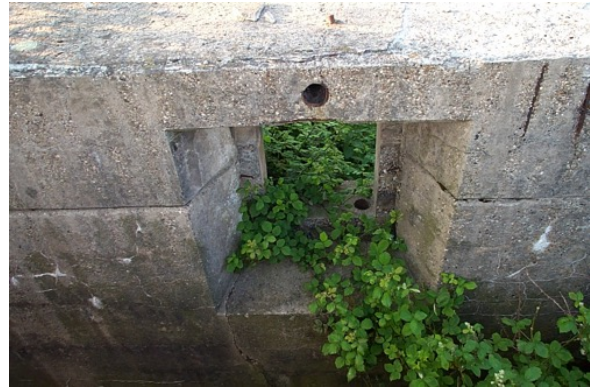
Een van de uitsparingen voor een raam in een kruitkamer, met luchtbuizen. (René Ros)
