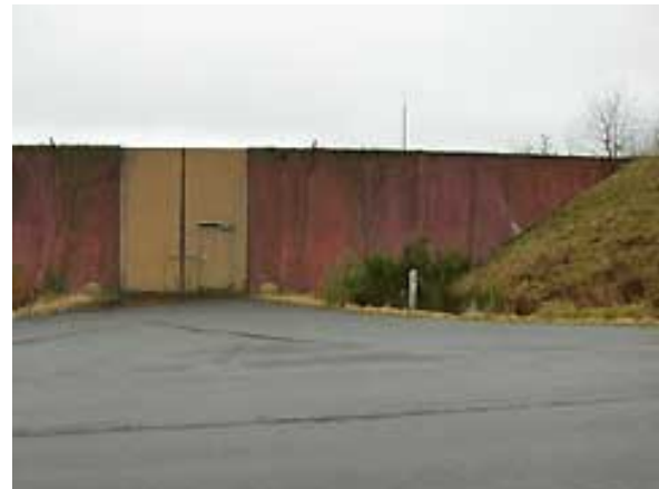
Scherfvrije opstelling voor Patriot Launching Station. (Ron Erhardt)
