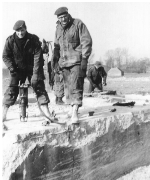
De eerder geboorde gaten zijn met een poetslap dicht gemaakt om te voorkomen dat er rommel in komt. (Wim Kiele, 1968)
