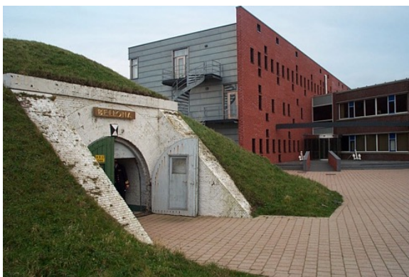
De oude poterne naar het zee-ravelijn met een modern gebouw. (René Ros)
