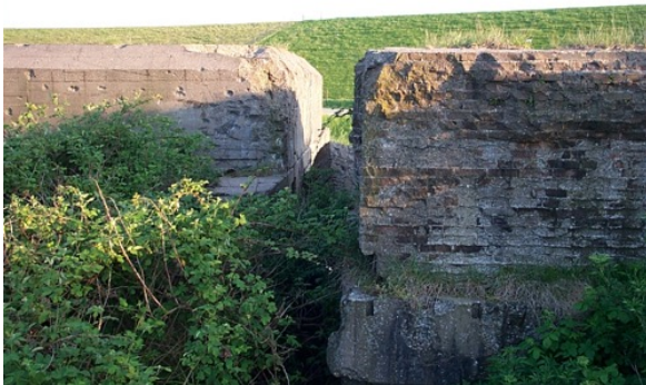
Twee delen van het dak op het rechter deel. Links afgewerkt, rechts is de bakstenen inhoud te zien. (René Ros)
