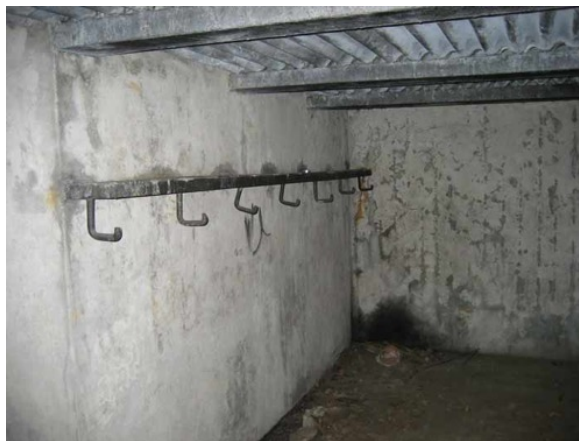
Een rek voor uitrustingsstukken in de schuilplaats uit 1939 op Redoute Schilde. (Ron Erhardt, 2009)
