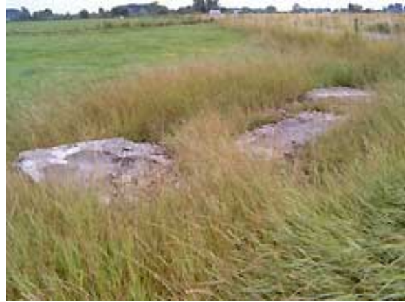
... met in het gras de grondplaat van S110 (S-Kazemat 110). (Erik Jan Eskes)
