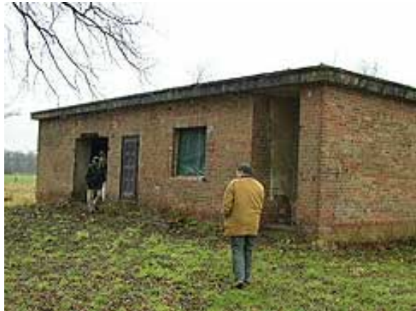
Gewapend betonnen gebouwtje t.b.v. Duitse Nachtjagd. (Ron Erhardt)
