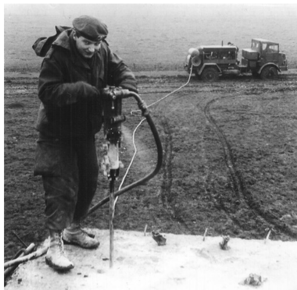
Gaten boren voor de explosieven. (Wim Kiele, 1968)
