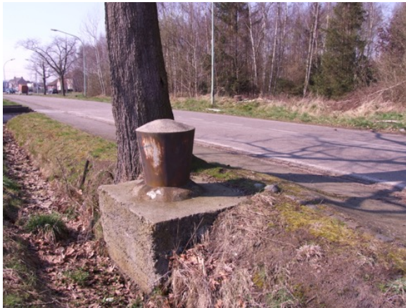
Twee ankerpalen voor de Cointet anti-tank hekken bij Peulis. (René Ros, 2009)
