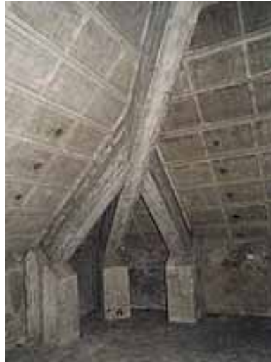
De betonnen spanten die het pannendak dragen. (René Roede)
