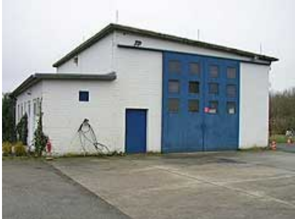
Assembly gebouw op de LA van Nordhorn. (Ron Erhardt)
