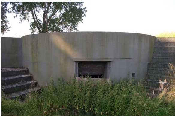
Intact linker hefkoepelgebouw van Fort bij Aalsmeer. (René Ros)
