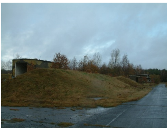
Links het warheads gebouw en rechts in de achtergrond de assembly building, beiden afgeschermd door aarden wallen. (René Ros)
