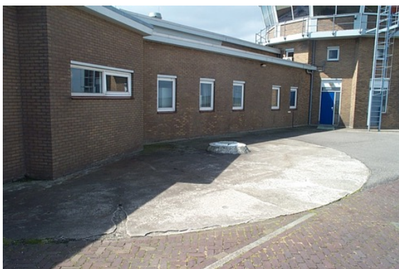
De cirkelvormige 'deksel' op de oostelijke geschuttschacht. In de westelijke is de toren gebouwd. (René Ros)
