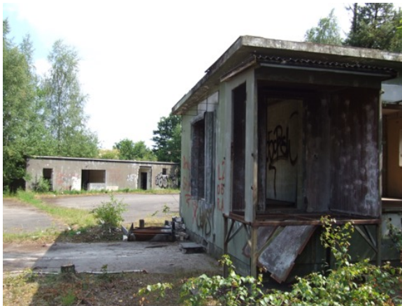
De interconnecting building voor opstelling van vier vrachtwagens met in op de achtergrond vermoedelijk de kantine. (René Ros)
