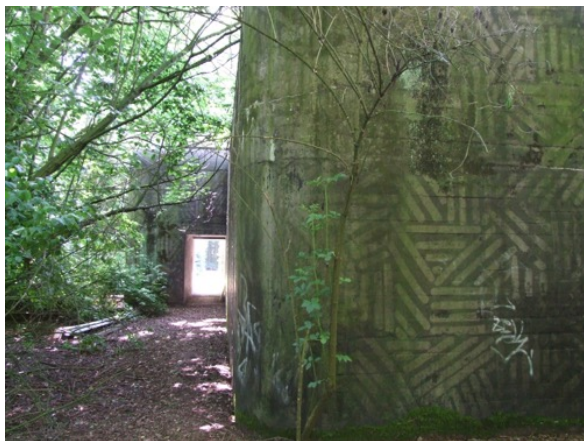
De noordoostzijde van de bunker met de personeels-toegang. (René Ros)
