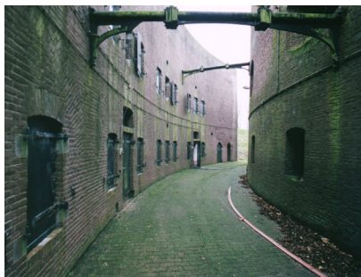
Fort Honswijk, de "Kalverstraat". Links de contrescarpgalerij en rechts de toren. (Anne Visser)
