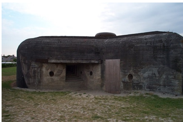
De Duitse mitrailleurbunker "112a neu" op het frontbastion (René Ros)
