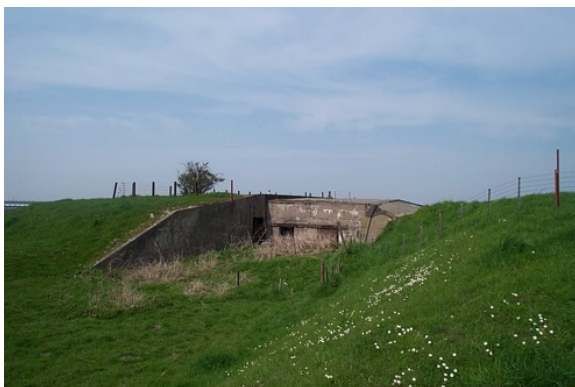
Kazemat van de Batterij aan de Sloterweg. (René Ros)
