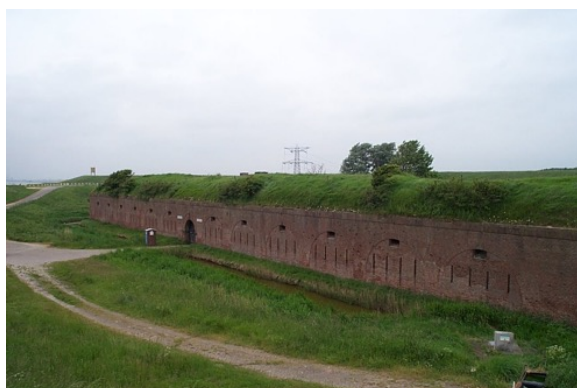
De frontzijde van het fort zoals gezien vanaf de oude zeedijk. (René Ros)
