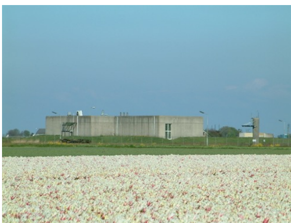
De OPS-bunker van het Navigatiestation N tussen de bollenvelden. (René Ros)
