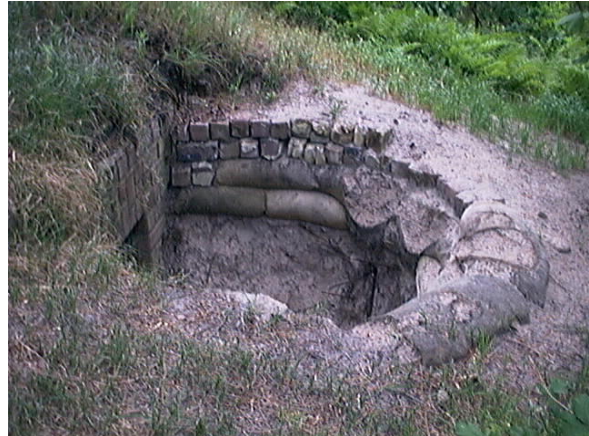
Westermient zandzakken (René Ros)
