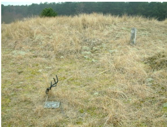
De metalen antennevoet, drie kabels en een van de drie houten tuipalen. (René Ros)
