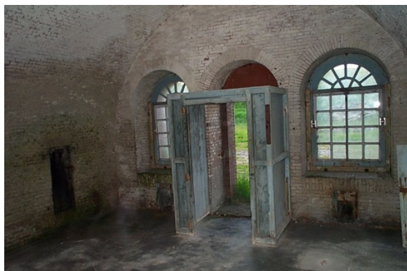
De keelwand van een van de lokalen met een houten voorportaal. (René Ros)
