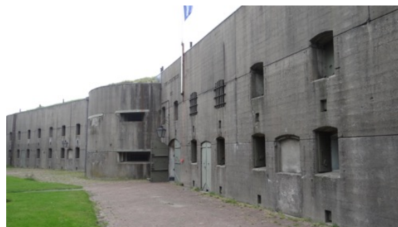
Keelzijde van de bomvrije kazerne van het Fort bij Spijkerboor, opgeleverd in 1913. (René Ros, 2014)
