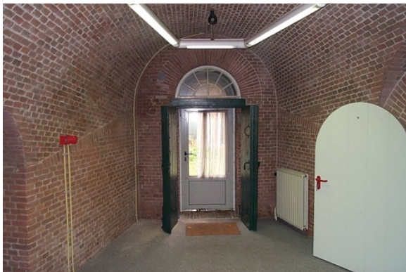
Enkele latere interieur-elementen zoals tl-verlichting, brandalarm, radiator en deuren, in de toren van het Fort aan de Uppelse Dijk. (René Ros, 2001)
