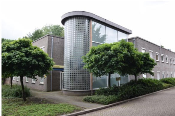
Toegang en trappenhuis van het gebouw T, het stafkantoor van Inlichtingen/Communicatie Detachement BLS op de Marechaussee-kazerne te Utrecht. (René Ros, 2020)
